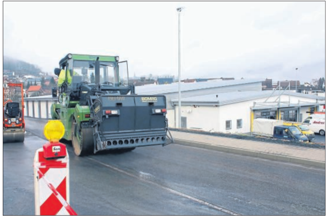
Der neue Edeka-Markt an der Marburger Straße in Battenberg: Gestern wurde die neu geschaffene Zufahrt asphaltiert. Zu sehen sind auch die hohen Beleuchtungsmasten. Foto: Hoffmeister
